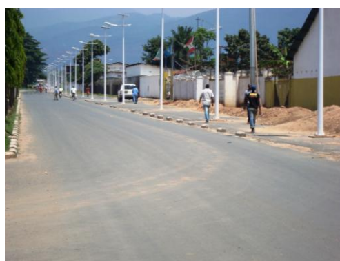
Photo 6 : Eclairage public par énergie solaire photovoltaïque dans la ville de Bujumbura.
