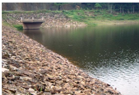
Photo 4 : Vue partielle du lac de retenue du barrage de Rwegura. Dans le coin haut gauche de la photo, l'évacuateur des crues (mai 2012).
