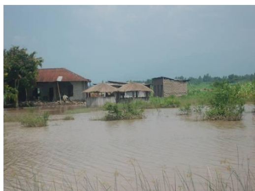
Photo3 : Inondation tout près de l'aéroport de Bujumbura.
